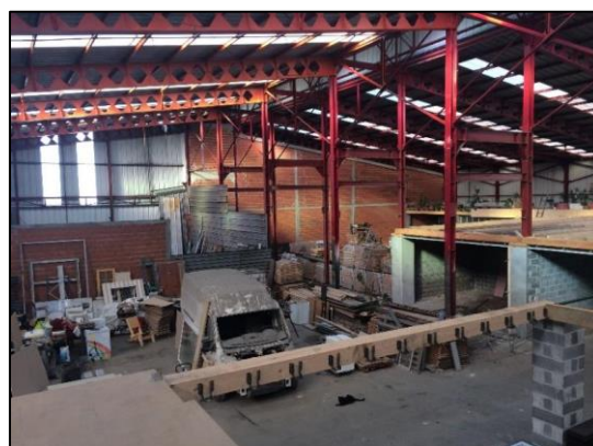
© Le Tiers Lieu Socopira vu de l'intérieur en cours de construction
