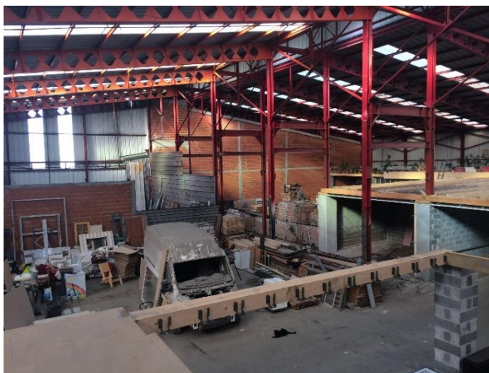
© Le tiers lieu Socopira vue de l'intérieur en cours de construction
