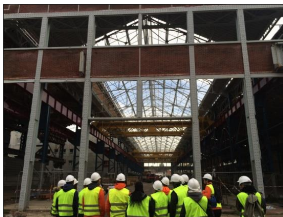
© Visite de chantier : la halle où sera implanté le futur Tiers Lieu
